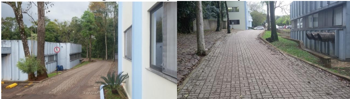
Figura 2: Caracterização física-externa do prédio
