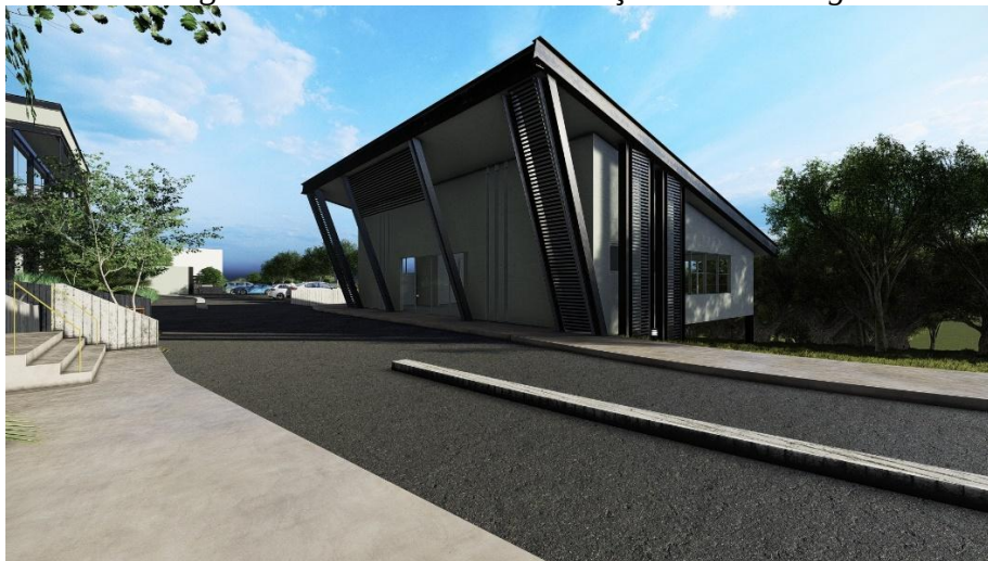
Figura 10: Bloco da Administração e Coworking .
