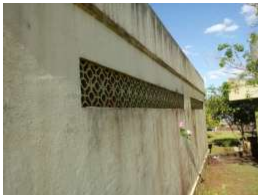
Imagem 10: Elementos vazados com cobogós
