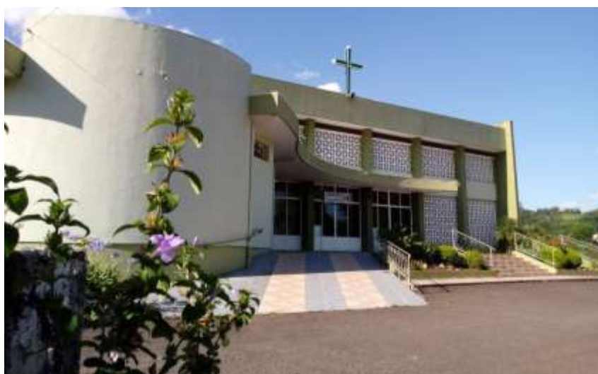
Imagem 03: Vista da Igreja Atual
