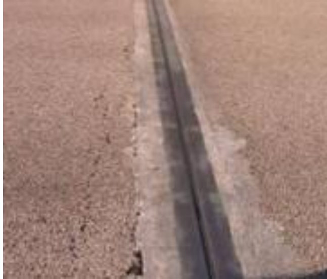
Figura 02: Material do tipo elastômero para junta de dilatação de estrutura
