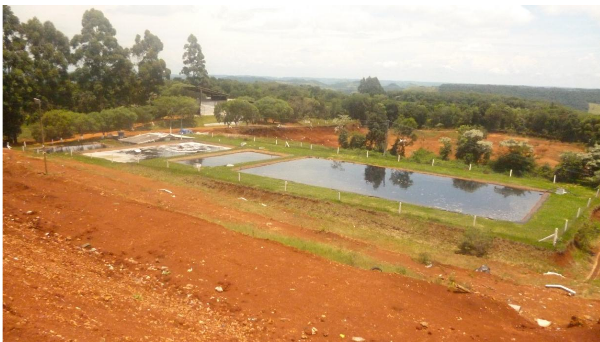
Figura 11 - Estação de tratamento do chorume
