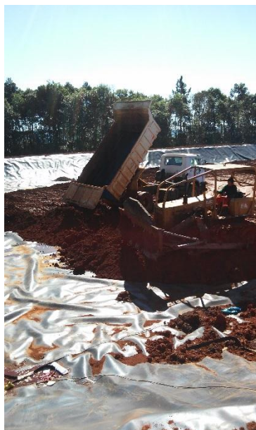
Figura 8 - Camada impermeabilizante
