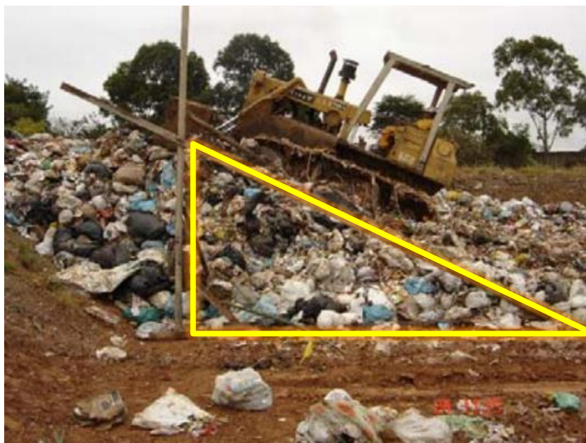
Figura 4 - Compactação de resíduos realizada em camadas inclinadas
